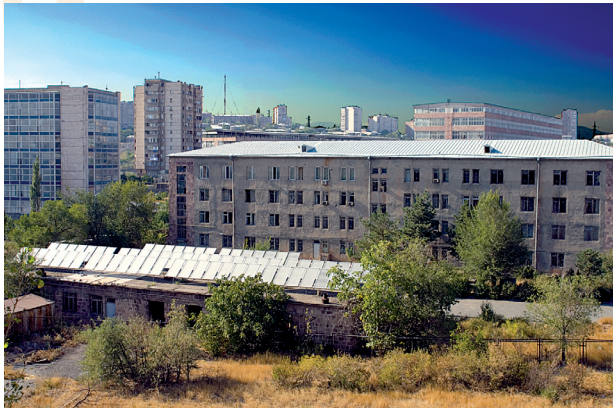
Picture 5: Finished installation at Narcologic clinic Նկար 5. Նկար. Աշխատանքների ավարտը Նարկոլոգիական կլինիկայում
