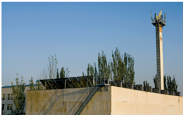
Picture 1: Installed collectors at the roof of RCC Նկար 1. կուտակիչի տեղակայում ԿՐ-ի տանիքում
