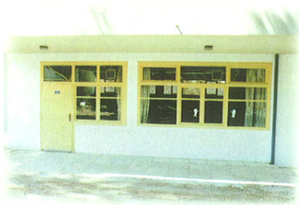
Εικ.25 Ανοίγματα αίθουσας με φεγγίτες και ανεμιστήρες
