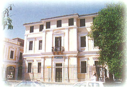
Εικ.7 Σχολείο νεοκλασσικό των αρχών του αιώνα
