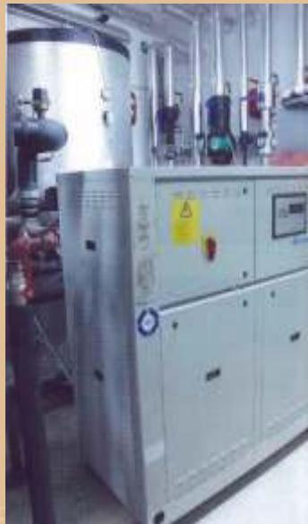
Η εναλλαγή θερμότητας με το έδαφος πραγματοποιείται με κατακόρυφους ΓΕΘ, οι οποίοι είναι κατασκευασμένοι από πολυαιθυλένιο υψηλής πυκνότητας, μέσω μίγματος νερού-γλυκόλης στο κύκλωμα κλειστού βρόχου. Οι γεωτρήσεις έχουν διάμετρο περίπου 11-13 cm και βάθος 100-150 m.
