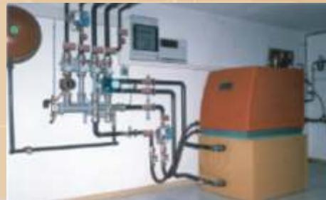
Το σύστημα ΓΑΘ περιλαμβάνει μία παραγωγική γεώτρηση και μια γεώτρηση επανεισαγωγής. Η παροχή του νερού γεώτρησης είναι περίπου 3.000 lt/h.
