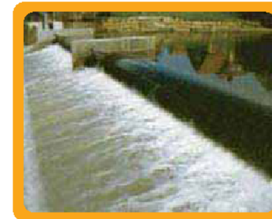
Σχήμα 22. Υδροφράκτης ενός μικρού υδροηλεκτρικού σχήματος εκτροπής [30]
