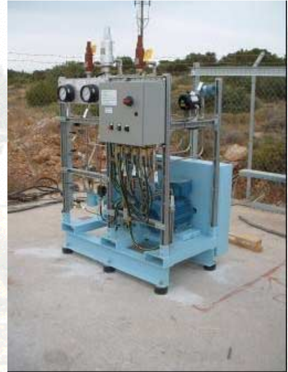
Τοποθέτηση μονάδας ηλεκτρόλυσης (Α) και συμπιεστή (Δ)
