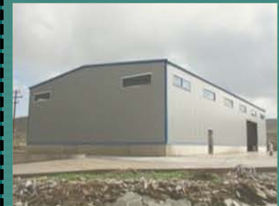
Ενεργειακα Βιοτεχνικα και Εμπορικα Κτιρια ΓΣΕΒΕ
