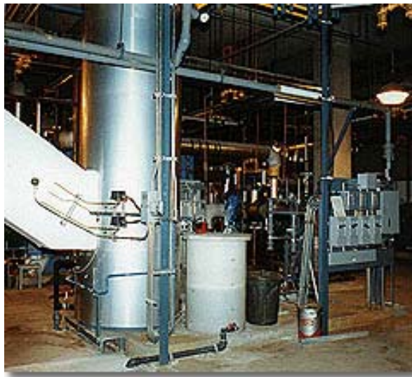
Σχήμα 13. Μονάδα ανάκτησης θερμότητας τοποθετημένη σε εργοστάσιο επεξεργασίας λυμάτων στο Κεμπέκ του Καναδά
