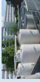
Φωτο 3. Αποψη του ξενοδοχείου Esperos Palace και του πρώτου συστήματος, 4 παγοκλινών, δυναμικότητας 2800 kWh.
