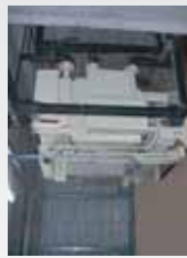
Φωτό 3. Ψύκτης απορρόφησης 105 kW
