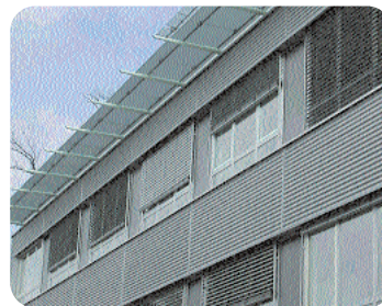
Φωτογραφία 3 Ηλιοπροστασία με οριζόντια πετάσματα και εξωτερικές περσίδες σε κτίριο γραφείων στη Δρέσδη (D)
