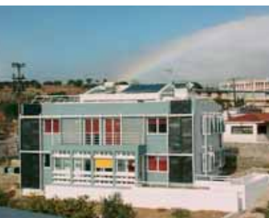
Βιοκλιματικό κτίριο ΚΑΠΕ
