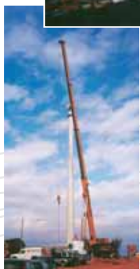
Εγκατάσταση ανεμογεννητριών στο αιολικό πάρκο του ΚΑΠΕ
