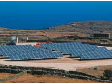
Φωτοβολταϊκή εγκατάσταση, Σίφνος
