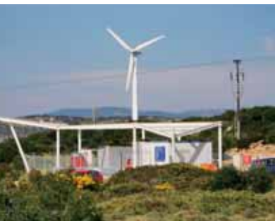
Μονάδα παραγωγής Υδρογόνου από αιολική ενέργεια στο αιολικό πάρκο του ΚΑΠΕ
