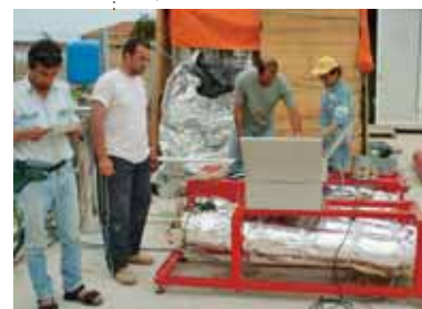
Εγκατάσταση μονάδας Υδρογόνου στο αιολικό πάρκο του ΚΑΠΕ
