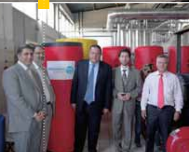
Εγκατάσταση πλιακών συλλεκτών σε νοσοκομείο του Ερυθρού Σταυρού στο Ερεβάν της Αρμενίας
