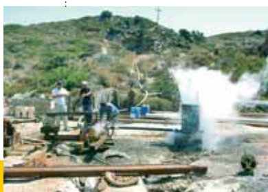
Δοκιμή Παραγωγής σε Γεωθερμική Γεώτρηση στη Μήλο
