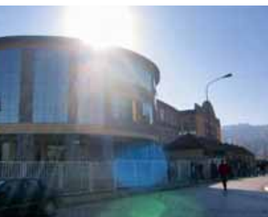
Εγκατάσταση ηλιακών συλλεκτών σε σχολικό συγκρότημα στη Σερβία
