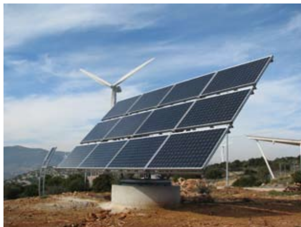
Φωτοβολταϊκό διαξονικό σύστημα παρακολούθησης του ήλιου
