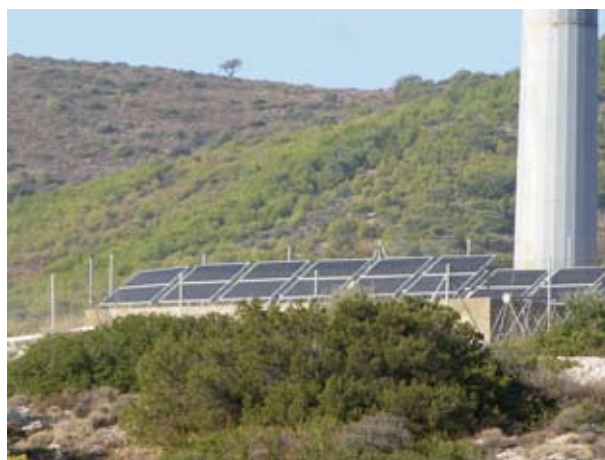
Αυτόνομη Υβριδική Μονάδα Αφαλάτωσης Θαλασσινού Νερού
