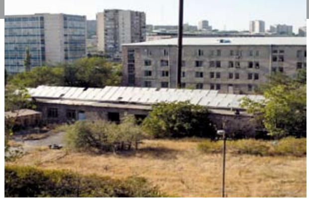
Ηλιακοί συλλέκτες εγκατεστημένοι, στη ναρκολογική κλινική του Ερεβάν στην Αρμενία
