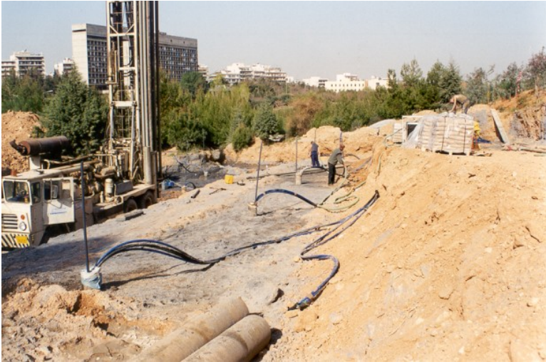
Εικόνα 14: Κτίριο Μεταλλειολόγων, κατακόρυφοι εναλλάκτες θερμότητας εδάφους κατά τη διάρκεια της κατασκευής.
