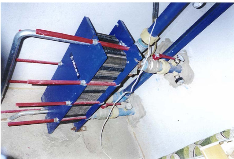
Εικόνα 2: Ξενώνας Τραϊανούπολης, κεντρικός εναλλάκτης θερμότητας.
