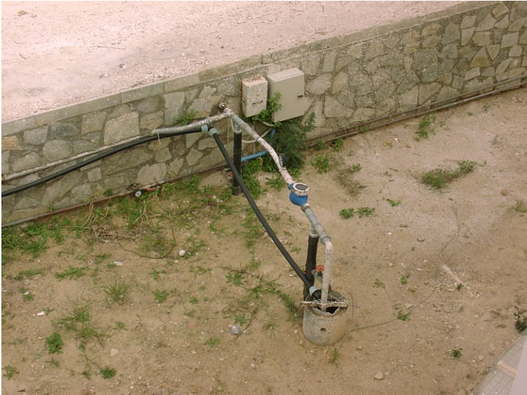
Εικόνα 10: Γραφεία ΚΑΠΕ, γεώτρηση που τροφοδοτεί τη γεωθερμική αντλία θερμότητας.
