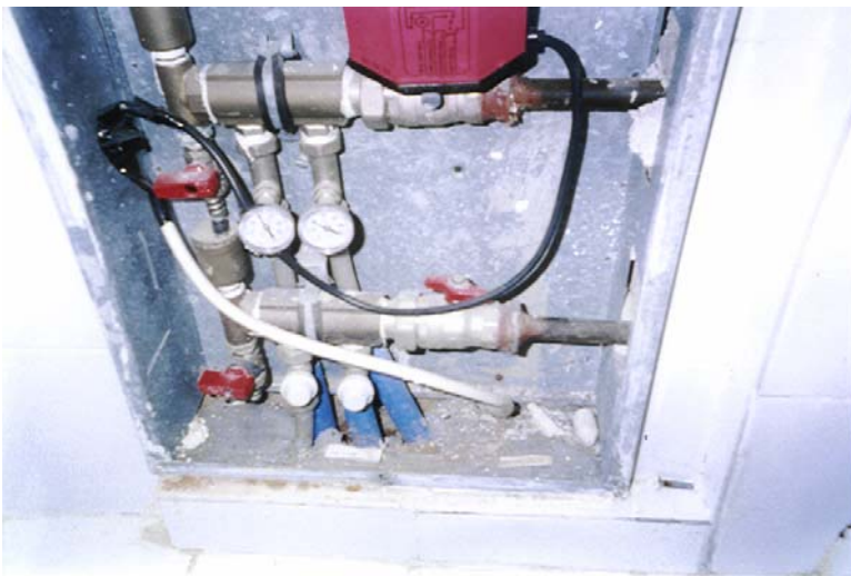
Εικόνα 4: Ξενώνας Τραϊανούπολης, λεπτομέρεια σύνδεσης ενδοδαπέδιου συστήματος.
