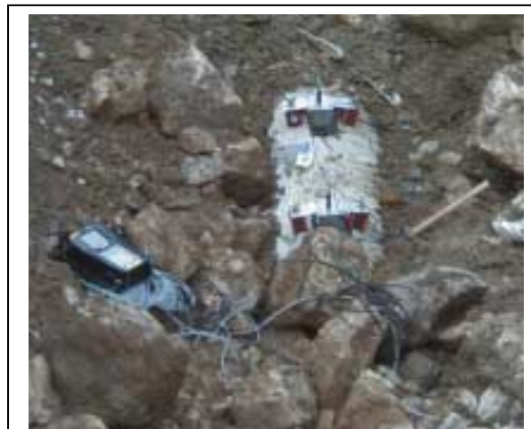
Τοποθέτηση αισθητηρίων μέτρησης παροχής σε θαμμένο αγωγό προσαγωγής ΜΥΗΕ
