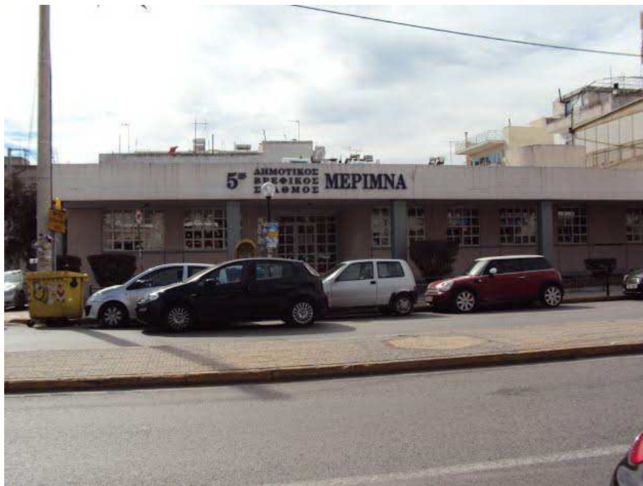
Ο βρεφονηπιακός σταθμός του Δήμου Αιγάλεω
