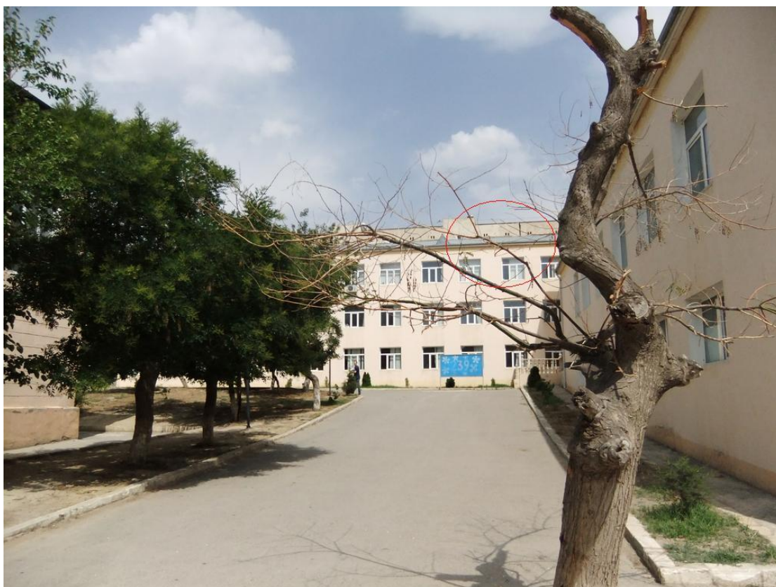
Εικόνα 3.3 Φωτογραφία του κτιρίου (ο χώρος εγκατάστασης του συστήματος είναι στην περιοχή που ορίζεται από την κόκκινη έλλειψη)
