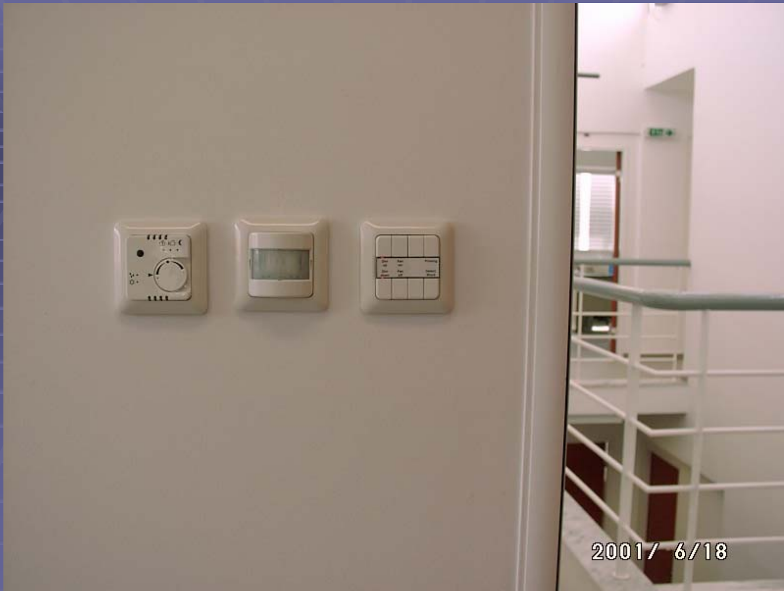
ΑΙΣΘΗΤΗΡΙΑ ΤΟΥ ΣΥΣΤΗΜΑΤΟΣ ΕΝΕΡΓΕΙΑΚΗΣ ΔΙΑΧΕΙΡΙΣΗΣ (ΘΕΡΜΟΚΡΑΣΙΑ ΑΕΡΑ ΧΩΡΟΥ, ΘΕΡΜΟΣΤΑΤΗΣ, ΑΙΣΘΗΤΗΡΙΟ ΠΑΡΟΥΣΙΑΣ, ΔΙΑΚΟΠΤΗΣ ΠΟΛΛΑΠΛΩΝ ΛΕΙΤΟΥΡΓΙΩΝ)
