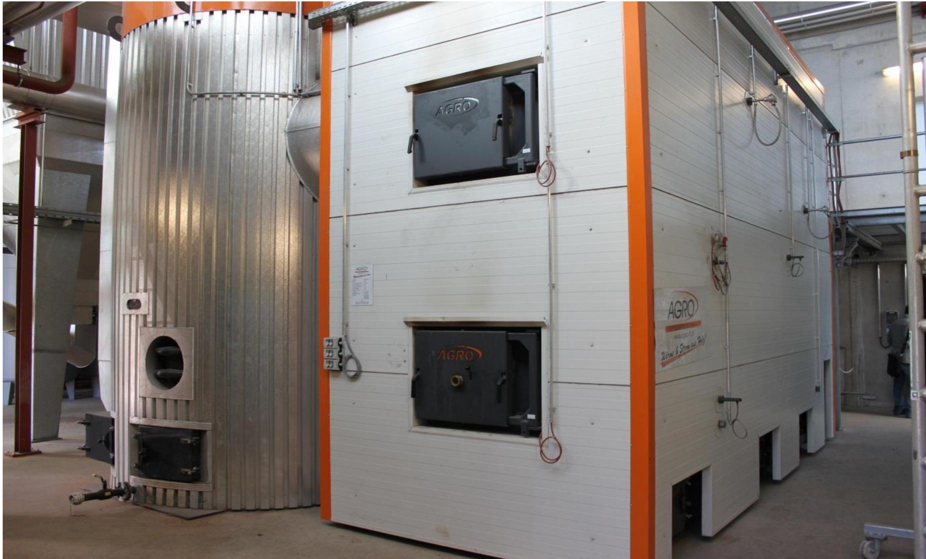
Σύστημα θέρμανσης με θρυμματισμένο ξύλο μεσαίας κλίμακας (3 MW) - λέβητας και δοχείο αδράνειας (Πηγή: Rutz D.)
