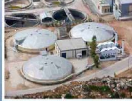
Κάλυψη Πρασινιτών με Γεωδρακούς Βόλους και Μονάδα Αποσποσης
