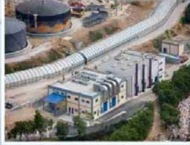
Α Κάλυψη Ανοικτού Καναλιού Λυμάτων Β Επέκταση Μονάδας Συμπαγωγής με Καύσιμο Βιοαέριο Ισχύος 4,25 MWe
