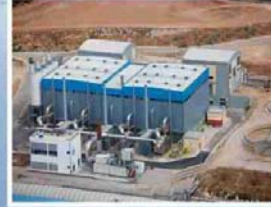
Νέα Μονάδα Συμπαγωγής με Καύσιμο Φυσικό Αέριο Ισχύος 12,9 MWe
