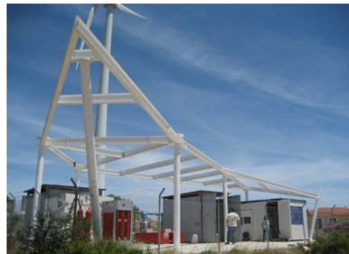
Γενική άποψη της μονάδας
