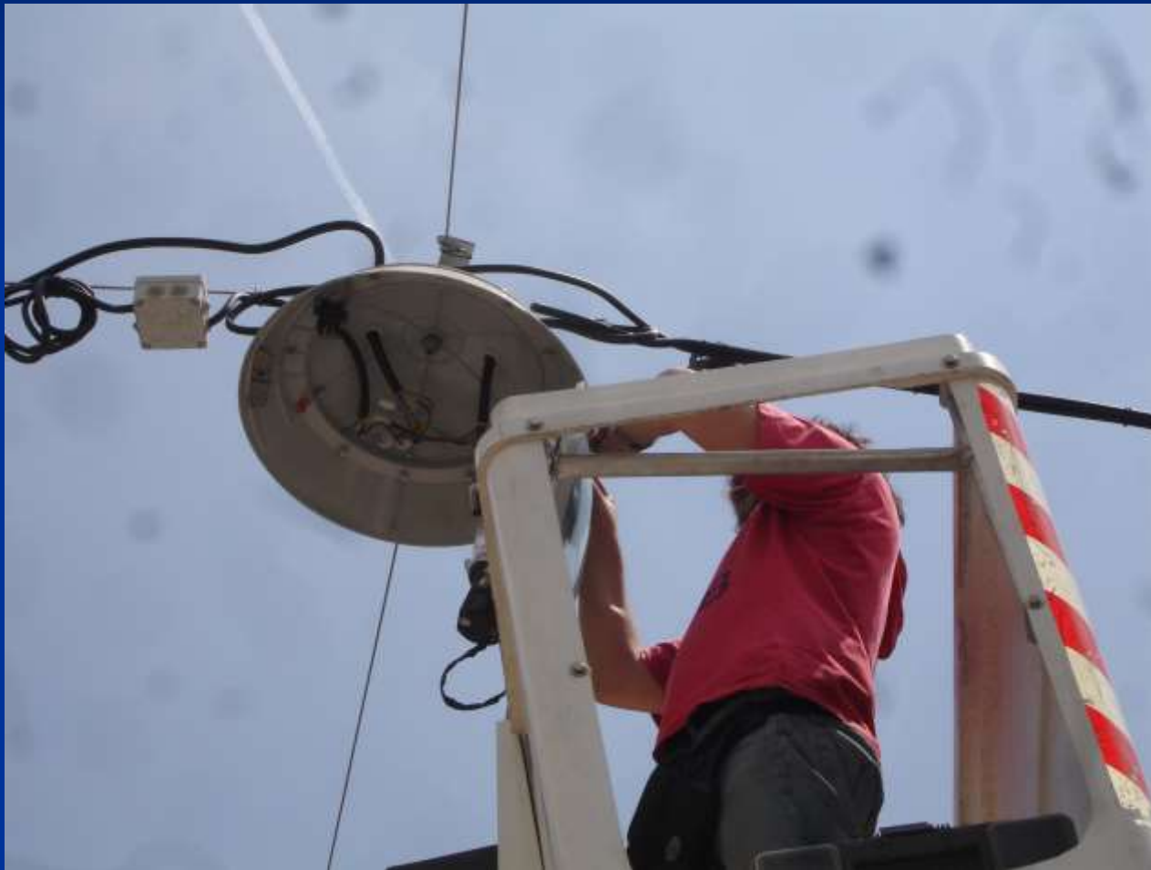
Τοποθέτηση Φωτιστικού Σώματος Δικτύου Οδοφωτισμού
