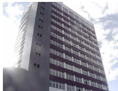
Ανακαίνιση κτιρίου γραφείων, Gabrono, Βουλγαρία
