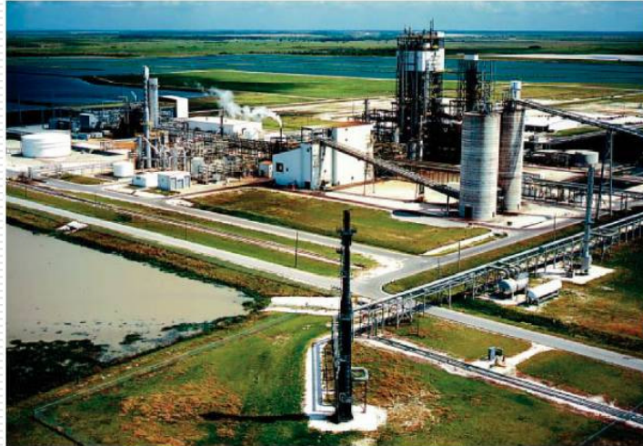
Η μονάδα 1 του σταθμού IGCC στο Polk (Mulberry, Φλόριντα, ΗΠΑ)
