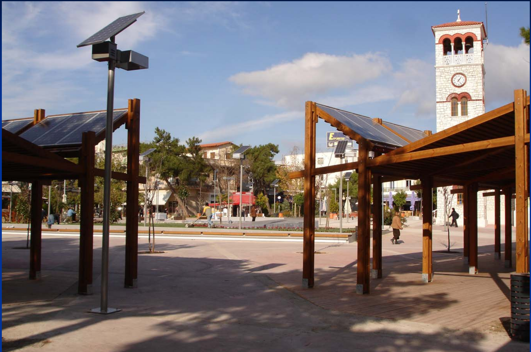
Διασυνδεδεμένο Φωτοβολταϊκό Σύστημα
