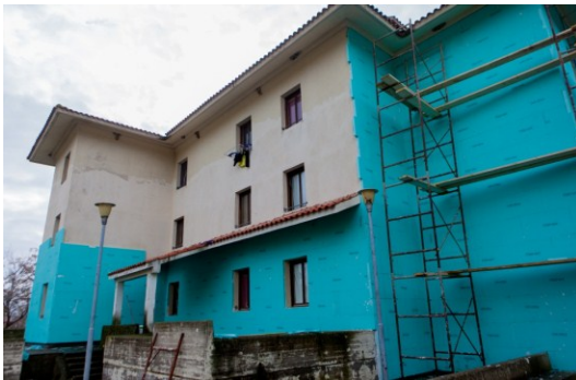
Εξωτερική θερμομόνωση - Κομοτηνή
