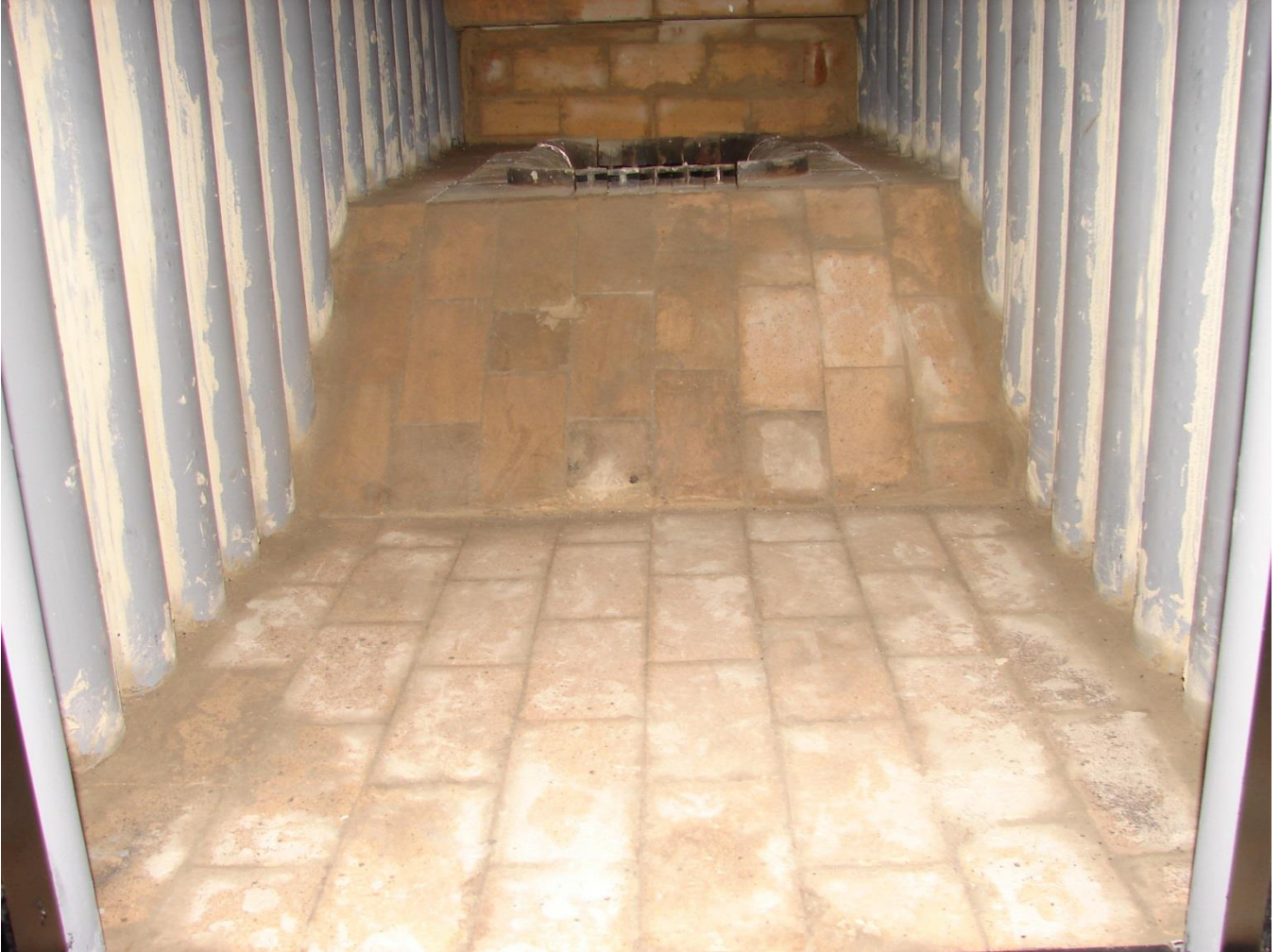
Ολοκληρωμένη επένδυση του εσωτερικού μεγάλου λέβητα με πυρίμαχα.
