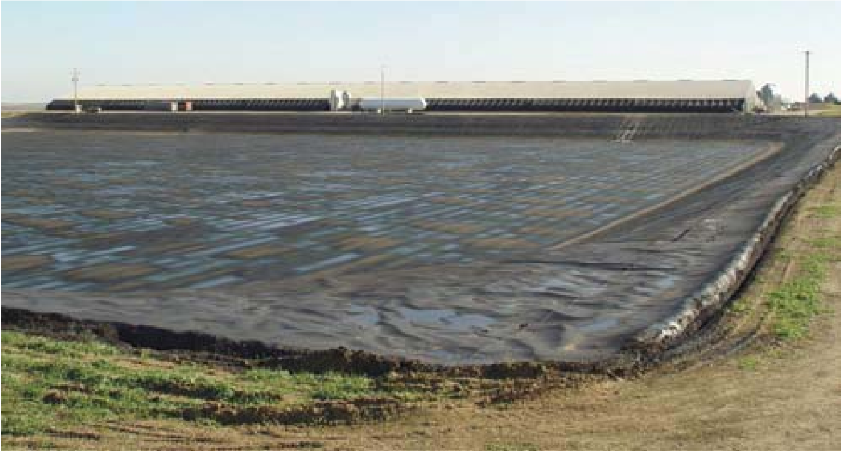
Δεξαμενή κοπριάς καλυμμένη με γεωύφασμα
