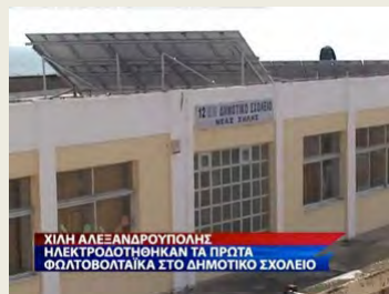
Εγκατάσταση Φ/Β σε σχολεία
