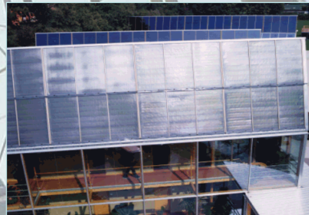
Ηλιακή θέρμανση νερού και υποστήριξη θέρμανσης στο Gleisdorf Αυστρίας
