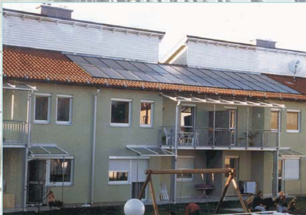
Ηλιακή μονάδα για θέρμανση νερού σε συγκρότημα κατοικιών, JJ-Fuxgasse, Gleisdorf, Αυστρία
