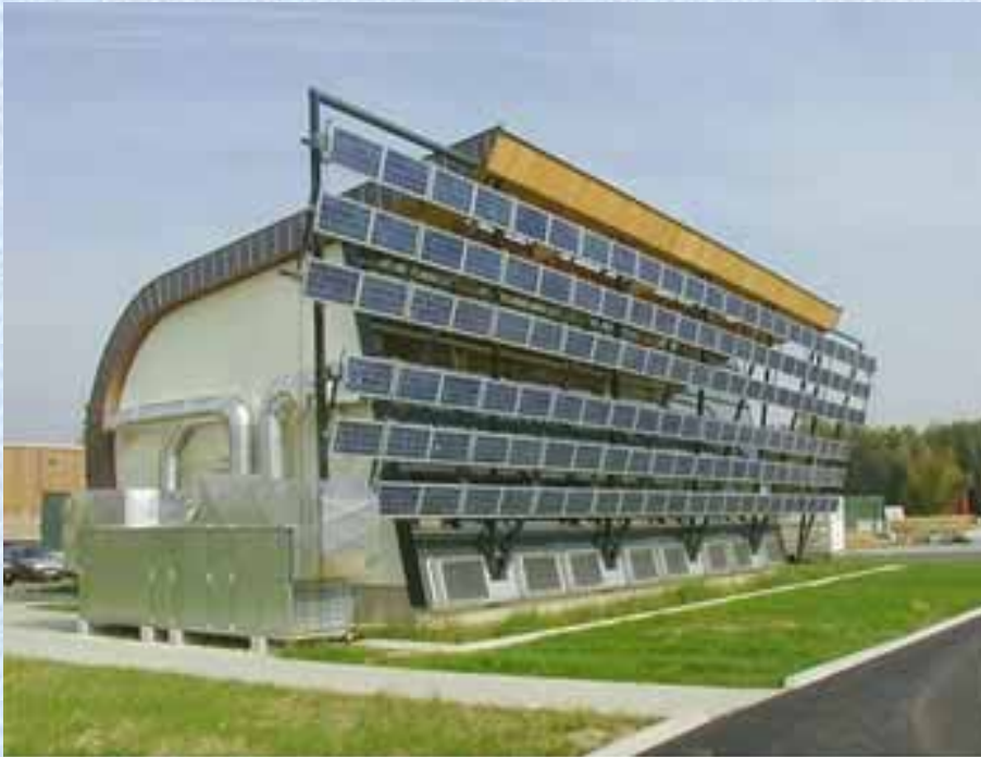
Άποψη του κτιρίου
