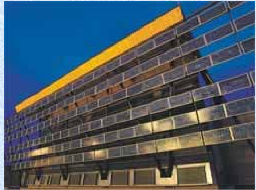
Άποψη της διάταξης των ηλιακών συλλεκτών
