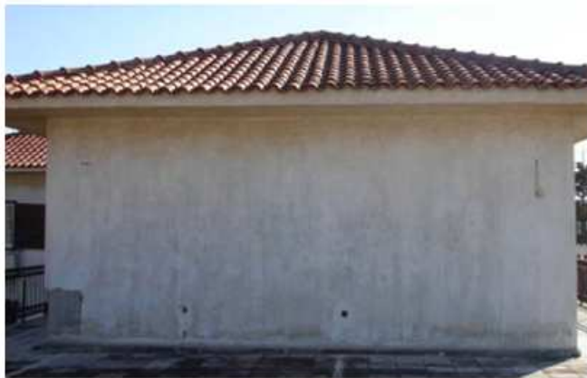
Βόρεια όψη 2 ου ορόφου
