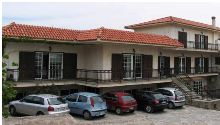
Άποψη Δυτικής Όψης
