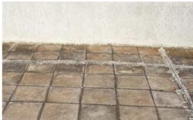
Δώμα 2 ου ορόφου
