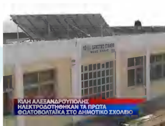
Εγκατάσταση Φ/Β σε σχολεία
