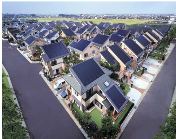
Φωτό 1: Η ηλιακή γειτονιά στην πόλη Kiyomino της Ιαπωνίας με εγκαταστάσεις 237 kWp σε κατοικίες μιάς γειτονιάς.
