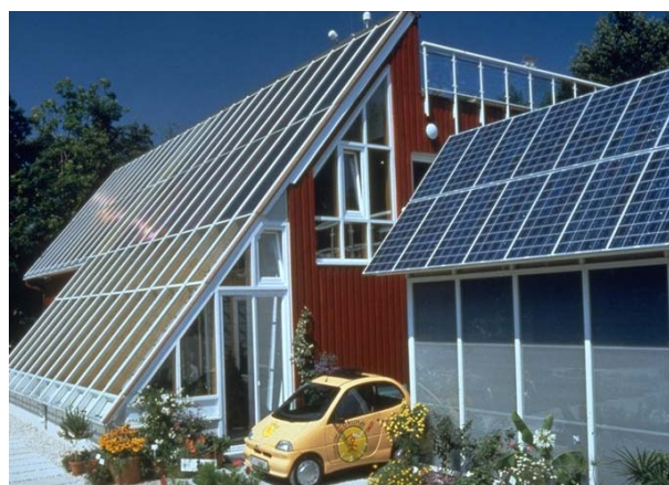
Φωτό 2: Φ/Β συστήματα τοποθετημένα σε όψεις και οροφές κτιρίων.
