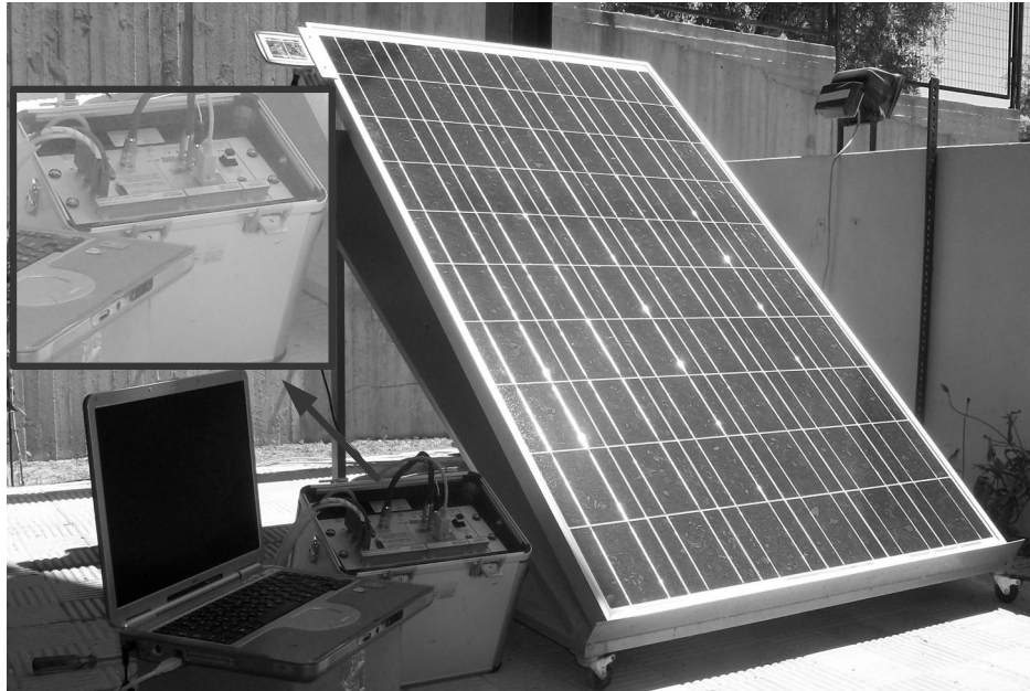
Σχήμα 1: Φωτογραφία του εξοπλισμού για τη μέτρηση της χαρακτηριστικής καμπύλης έντασης-τάσης ενός Φ/Β πλαισίου με τη βοήθεια του ηλιακού φωτός.
