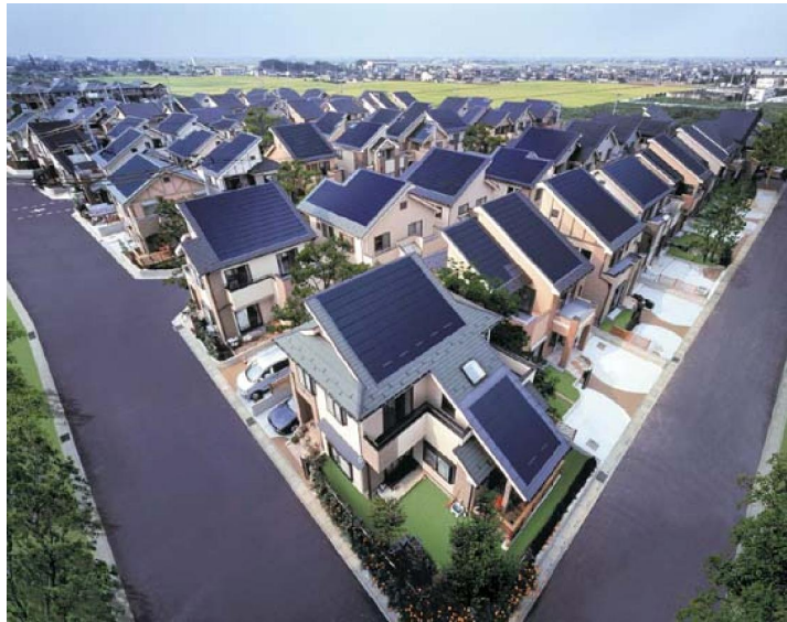
Φωτό 1: Η ηλιακή γειτονιά στην πόλη Kiyomino της Ιαπωνίας με εγκαταστάσεις 237 kWp σε 80 κατοικίες μια γειτονιάς.
