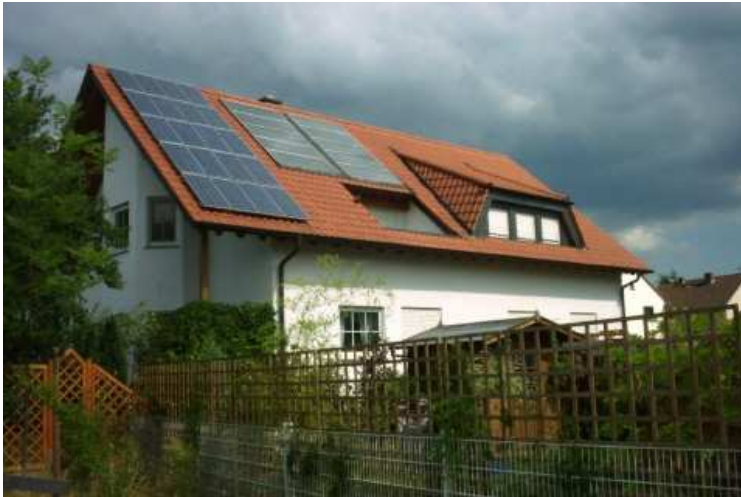
Dach eines Wohnhauses mit Solarzellen
