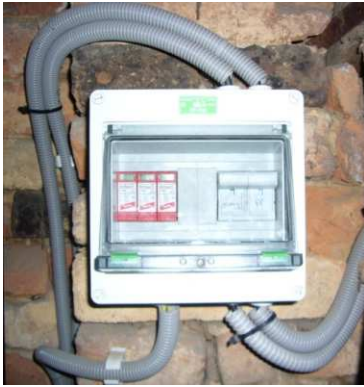
Pendelsperre mit Trennschalter - Wechselrichter SMA
