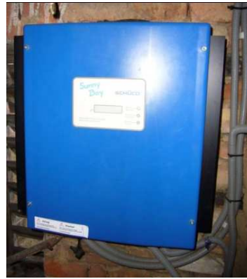
Pendelsperre mit Trennschalter - Wechselrichter SMA
