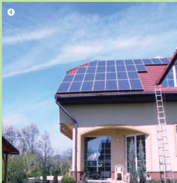
Фотоволтаична система в жилищна сграда в гр. Брeзова, Чехия (инсталирана мощност – 4,35 kW e ) Източник: Hitech Solar s.r.o.
