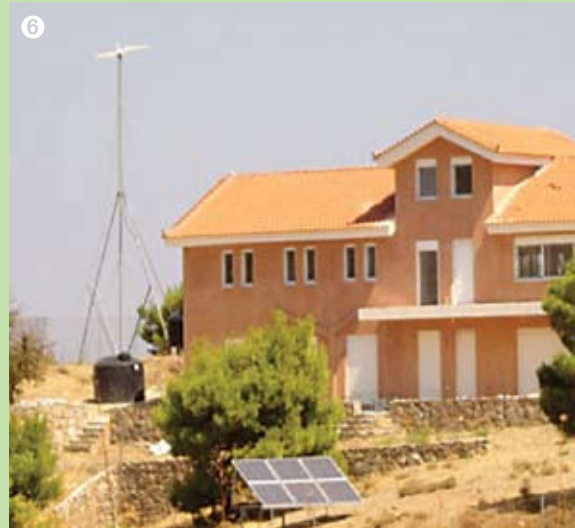
Hybridanlage mit einem 1,5-KW-Windrad bei einem Haus in Grammatiko in Griechenland.
