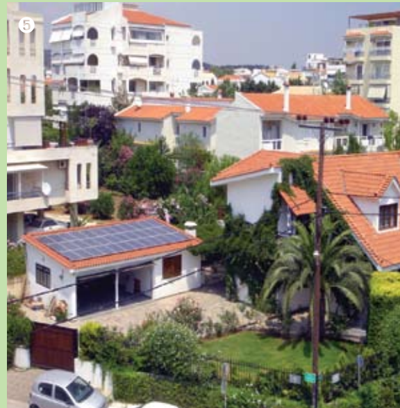
Eine Photovoltaikanlage mit 6 KW Leistung bei einem Wohnhaus in Athens Vorort Voula. Quelle: Data energy
