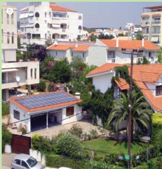
Φ/Β σύστημα 6KW σε κατοικία στη Βούλα Πηγή: Data energy
