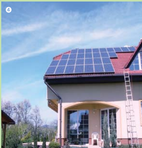
Fotovoltaický systém v rodinném domě, obec Bězová, Česká Republika. Instalovaný výkon 4,35kWp, Zdroj: Hitech Solar s. r. o.
