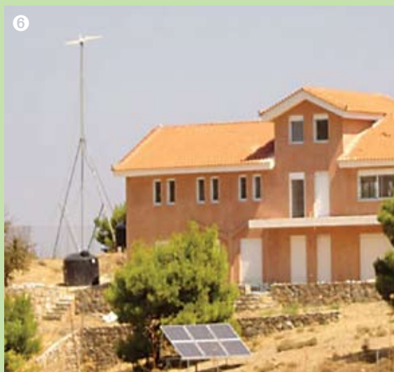
Hybridní zařízení s 1,5 kWp v trnův turbínou v domě v Grammatiko, Řecko Zdroj: Alexakis Energy
