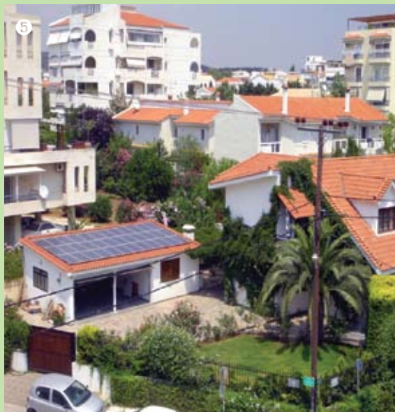
Fotovoltaické zařízení o instalovaném výkonu 6 kWp v rodinném domě na Voula regionu v Athénách Zdroj: Data ENERGY
