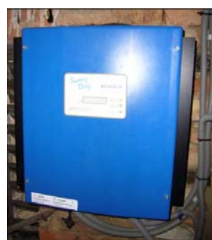
Защита с ключ-разединител - Инвертор SMA
