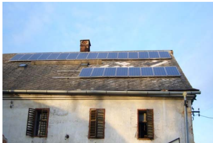
Местонахождение на PV панелите
