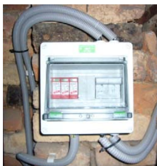
Защита с ключ-разединител - Инвертор SMA
