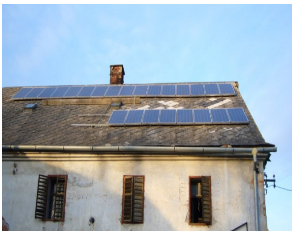
Umístění panelů na střeše
