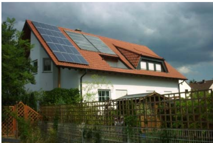
Sistema FV montado numa residencial
