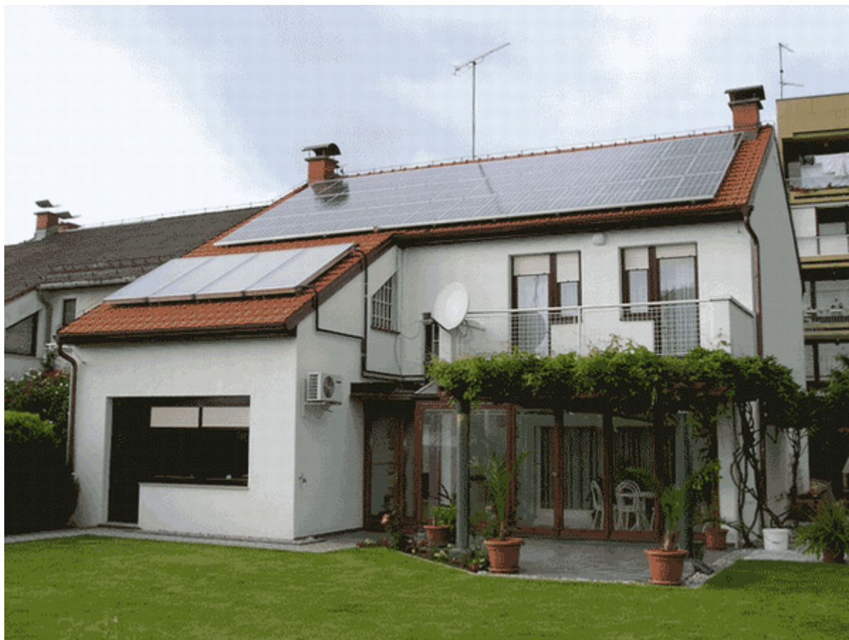
Slika12 Solarni krov u Španskom, Zagreb s ravnim pločastim kolektorima i fotonaponskim modulima (Izvor: EIHP)
