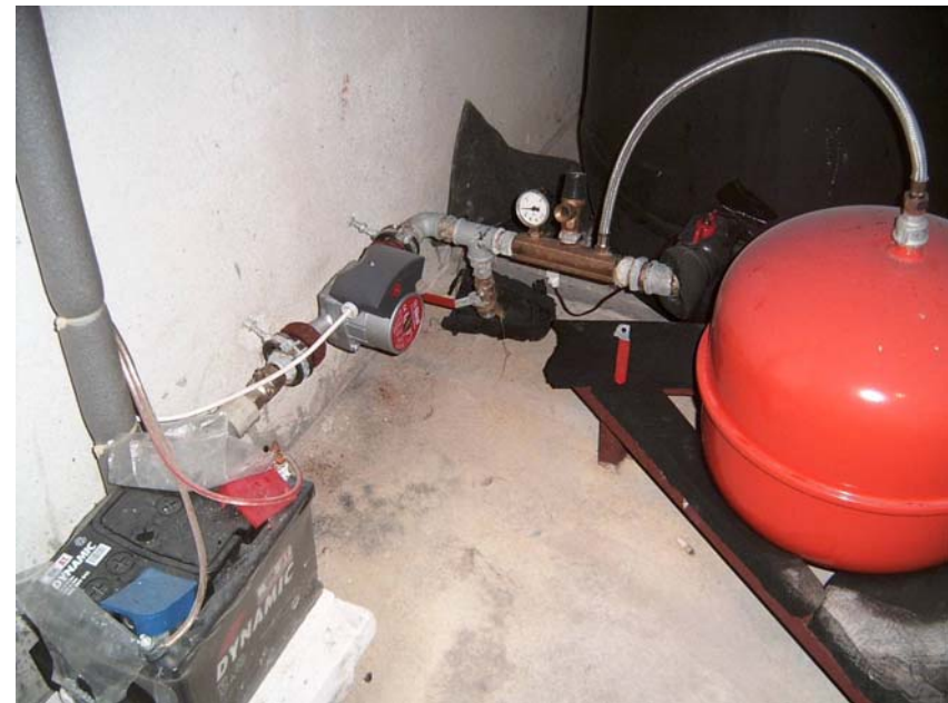
соларна помпа, разширителен резервоар
