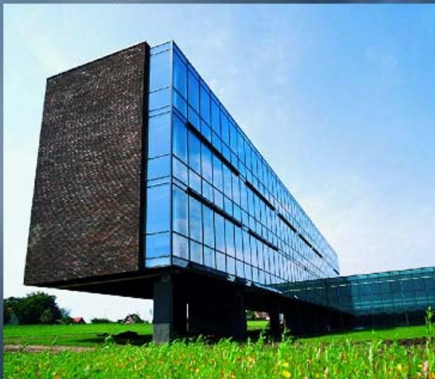
Изглед на офис сградата и визуализация на въздушните течения в нея
