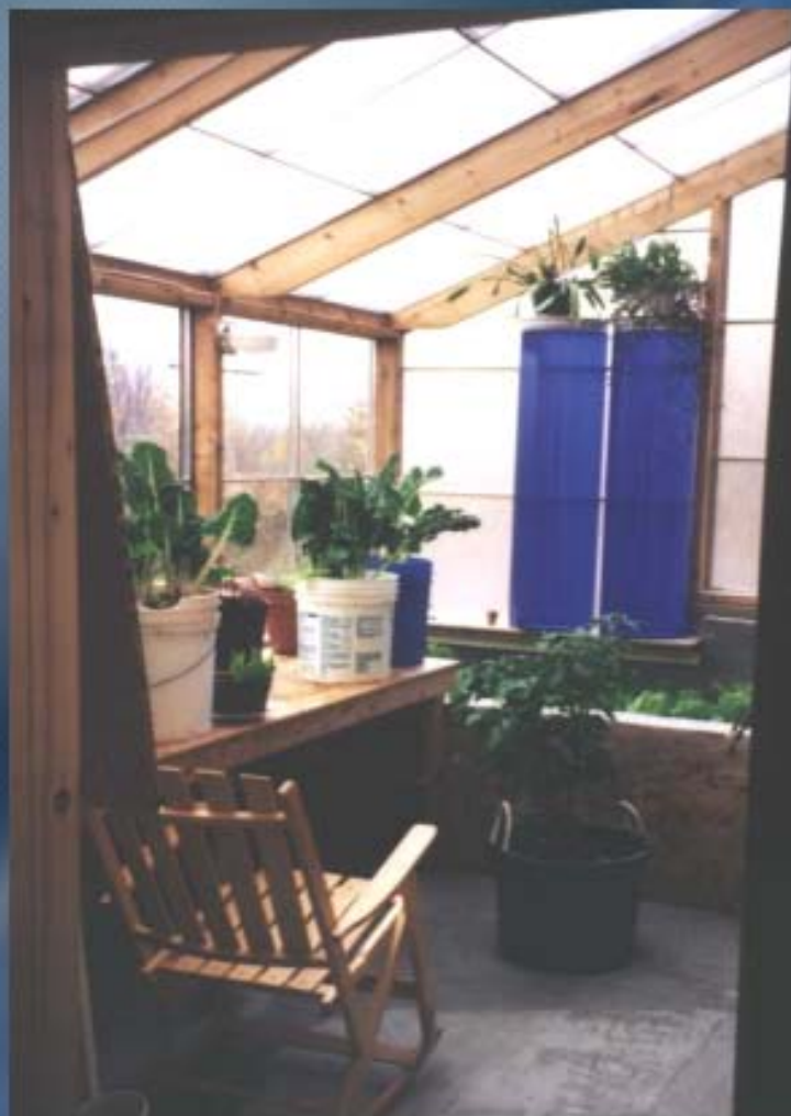
Изглед на интериор на слънчевото пространство с изградени стъклени цилиндри пълни с вода
