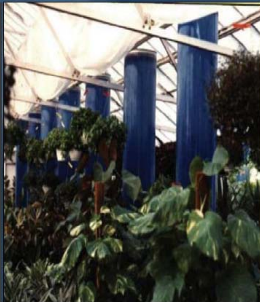
Изглед на интериор на слънчевото пространство с изградени стъклени цилиндри пълни с вода
