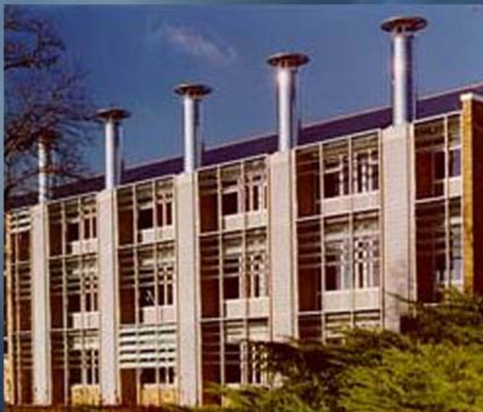
Слънчеви комини в Уатфорд, Англия, изглед и принципна схема на действие
