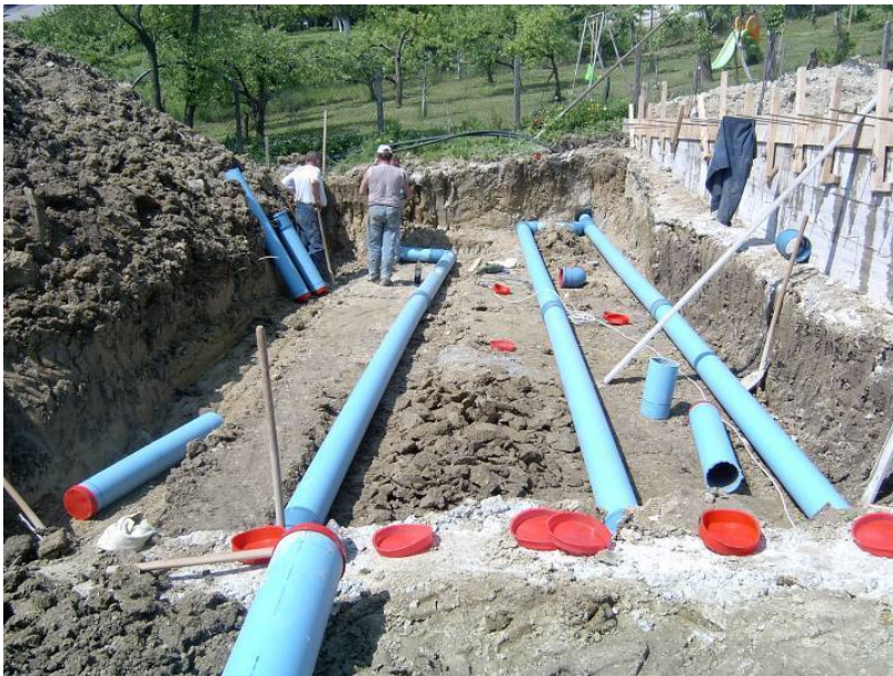
Kolektorske cijevi u zemlji tijekom izgradnje
