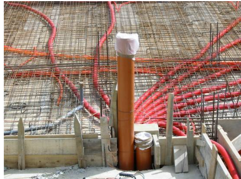
Ventilacijski razvod u kući prije zalijevanja betonom
