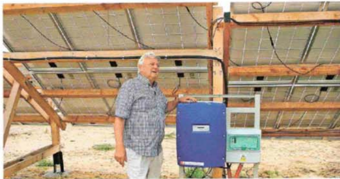
Měsíce jako důležitá součást solární elektrárny byvalí lidé při eskurzích z publicitě stranou pozornosti laické veřejnosti, avšak právě správná volba poměru jejich výkonu k výkonu elektrárny předurčuje finanční zisk investora
