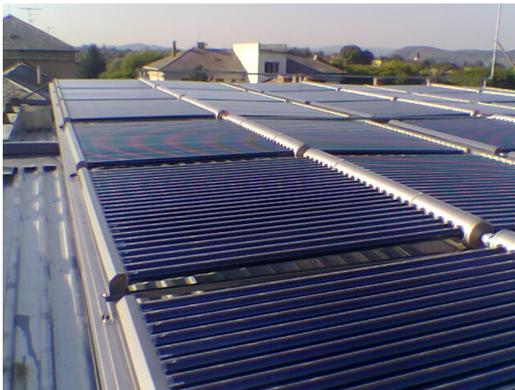
Figure 22: Szolár termál kollektor egy kórházon (Forrás: Kardos Labor Kft)
