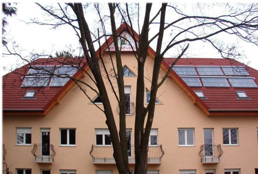
Figure 24: Szolár termál kollektor egy hotelen (Forrás: Kardos Labor Kft)
