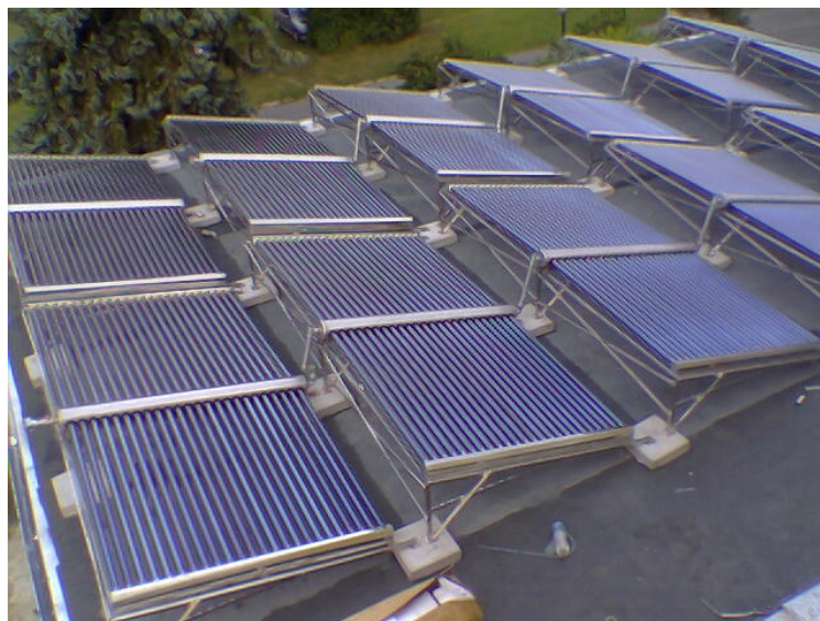
Figure 23: Szolár termál kollektor egy kórházon (Forrás: Kardos Labor Kft)
