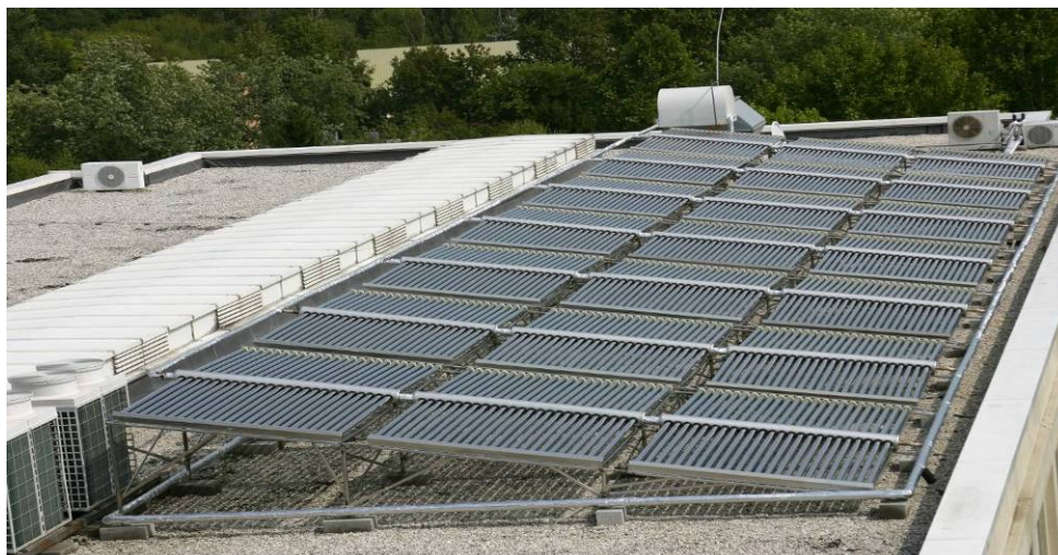
Figure 25: Szolár termál kollektor egy hotelnél (Forrás: Kardos Labor Kft)
