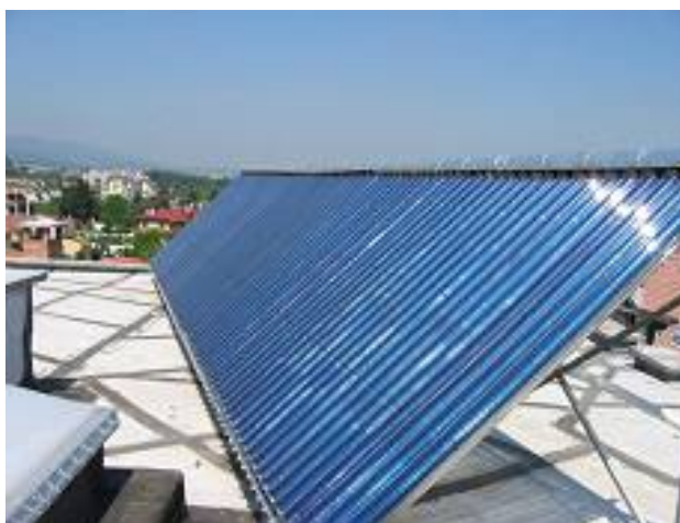
Фигура 14: Колектори на покрива на жилищната сграда в кв. Симеоново
