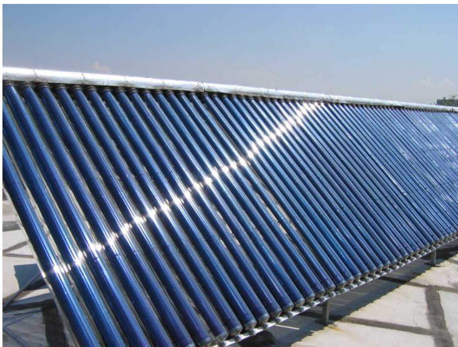
Фигура 12: Вакуумно-тръбни колектори, монтирани в хотел „Иберостар“, Слънчев бряг
