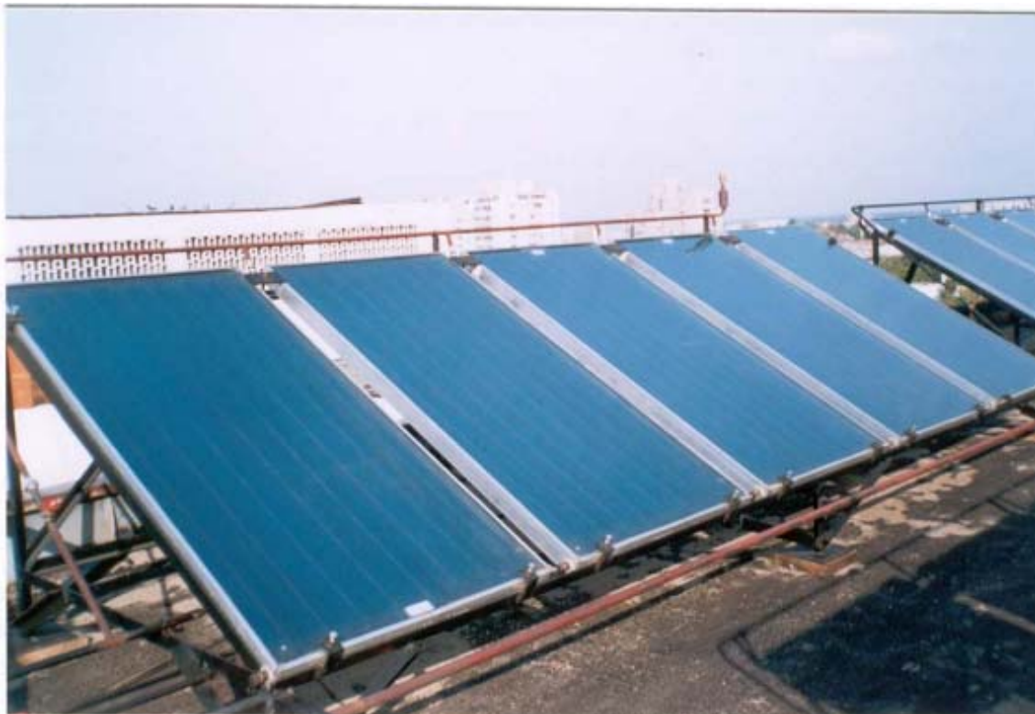
Фигура 11: Плоски пластинчати колектори в Дома за възрастни хора в гр. Силистра, България
